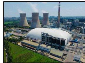
图 7 发电厂煤棚膜结构
